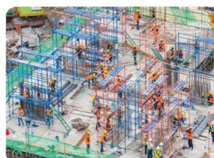
GENERALNE WYKONAWSTWO W ZAKRESIE BUDOWY I FIT-OUT
