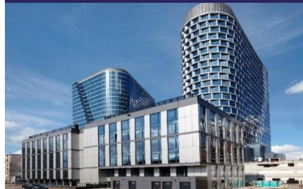
Katowice, ul. Mickiewicza
