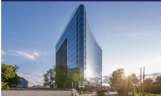
Wrocław, ul. Fabryczna
