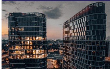
Katowice, ul. Mickiewicza
